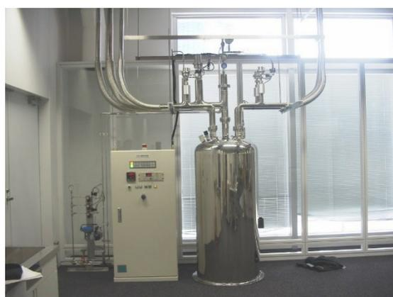
真空断熱配管(V.J.P.)と気液分離器
