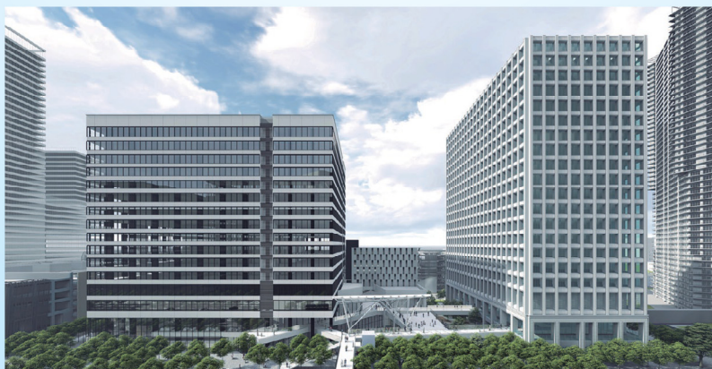
(仮称)豊洲4-2街区開発計画B棟(図左) *事業者:株式会社IH、三菱地所株式会社、設計者・施工者:鹿島建設株式会社
